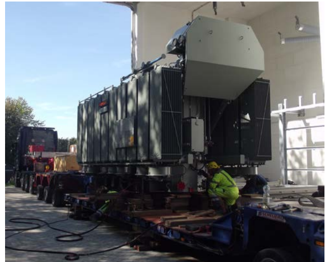
Bild oben: Anlieferung des Netztrafos.
