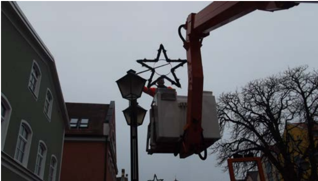
Anbringung der Weihnachtsbeleuchtung durch einen Monteur in der Langen Zeile.
