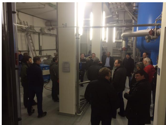
Hier sind die interessierten Teilnehmer bei der Führung im Rohrkeller/Wasseraufbereitung zu sehen.
